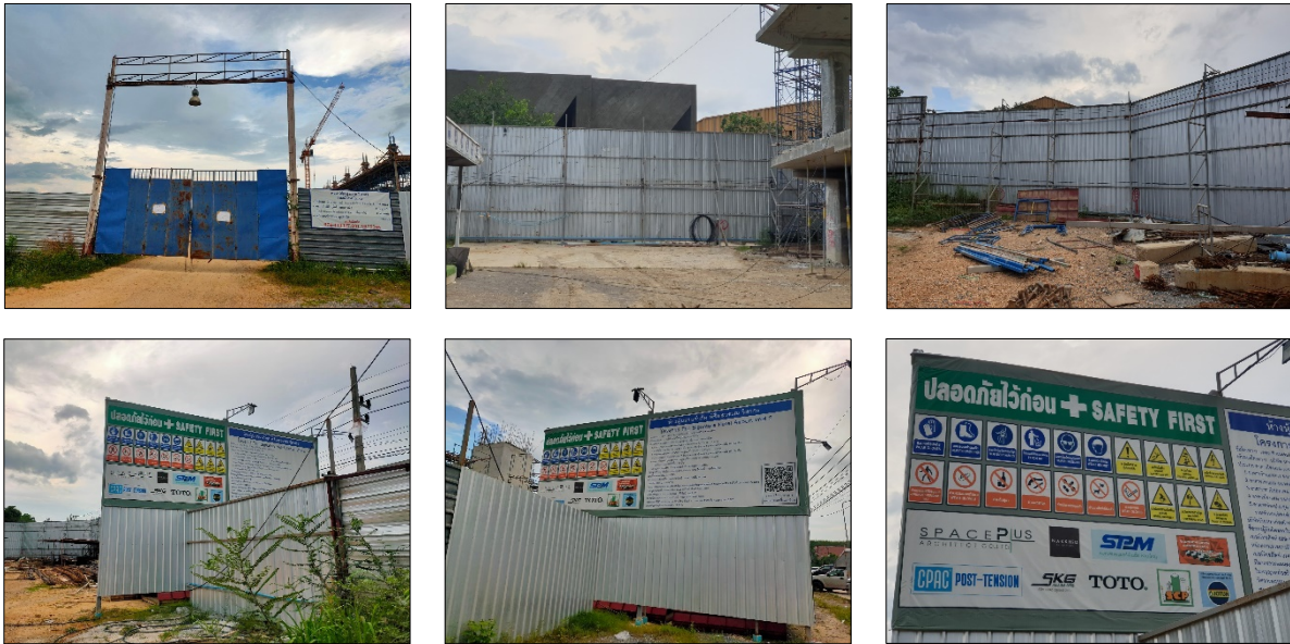
รูปที่ 3.2-1 การจัดทำรั้วและประตูด้านหน้าพื้นที่ก่อสร้าง พร้อมการติดตั้งป้ายเตือน ป้ายประกาศ ระบุชื่อ-ที่อยู่ หมายเลขโทรศัพท์ ที่สามารถติดต่อได้
